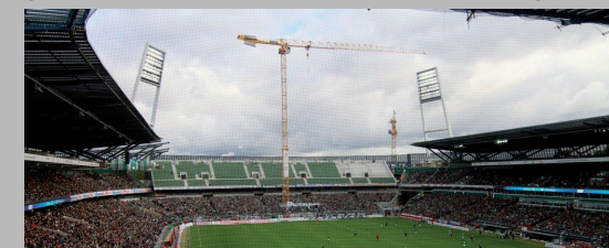
Nicht nur das Weserstadion ist derzeit eine Baustelle.
